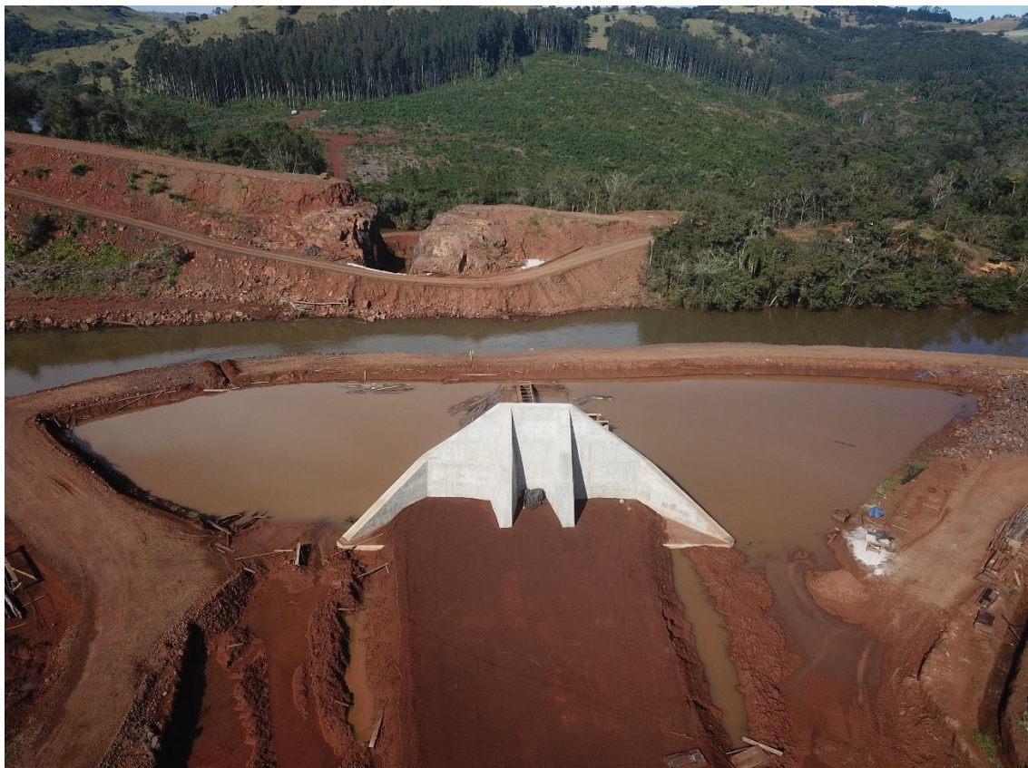
Figura 8 - Local onde está sendo construída a barragem da CGH Tapera 2A, 15/06/2022.
