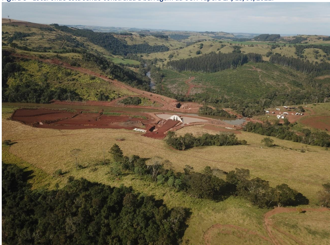
Figura 9 - Local onde está sendo construída a barragem da CGH Tapera 2A, 15/06/2022.
