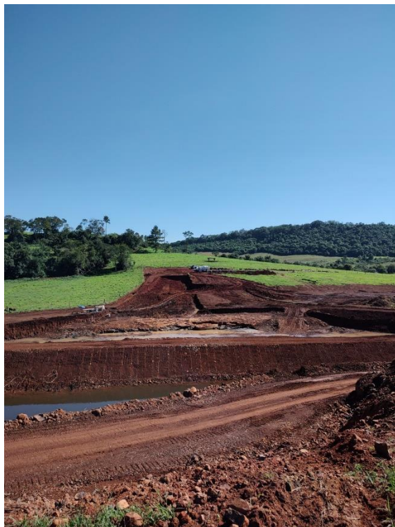
Figura 3 - Local onde está sendo construída a barragem da CGH Tapera 2A, 04/03/2022.
