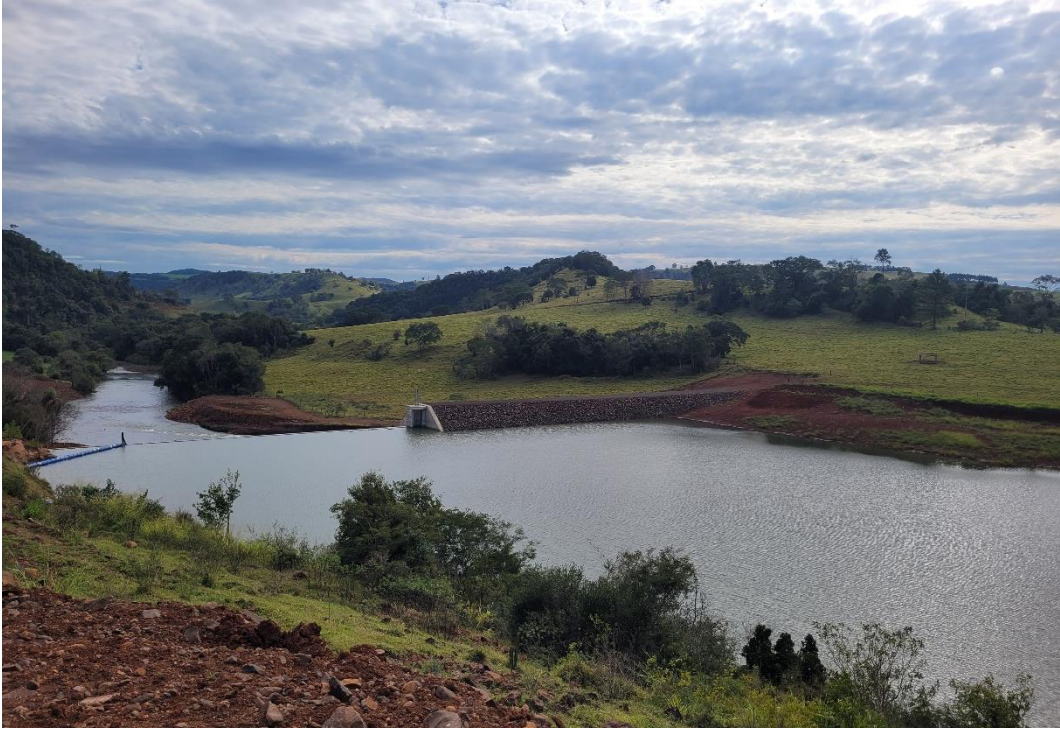
Figura 3 – Vista da barragem concluída (junho/2023).
