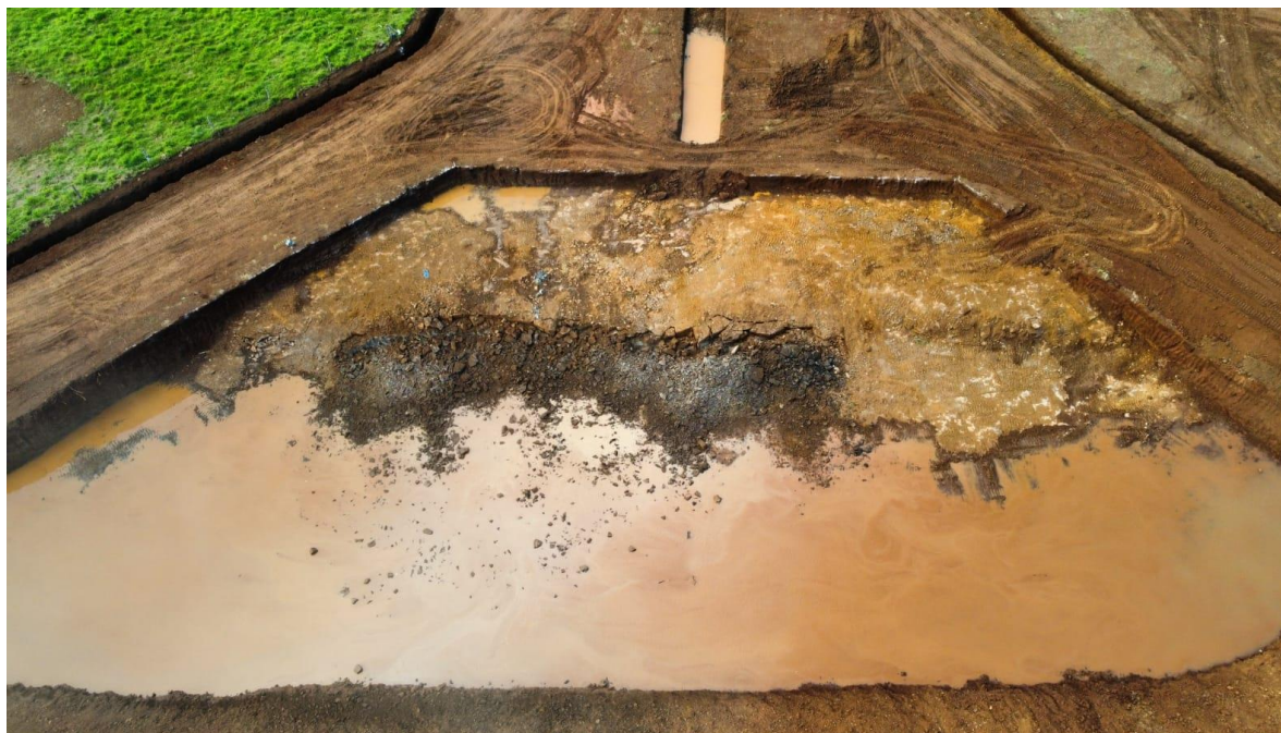
Figura 2 - Local onde está sendo construída a barragem da CGH Tapera 2A, 04/03/2022.
