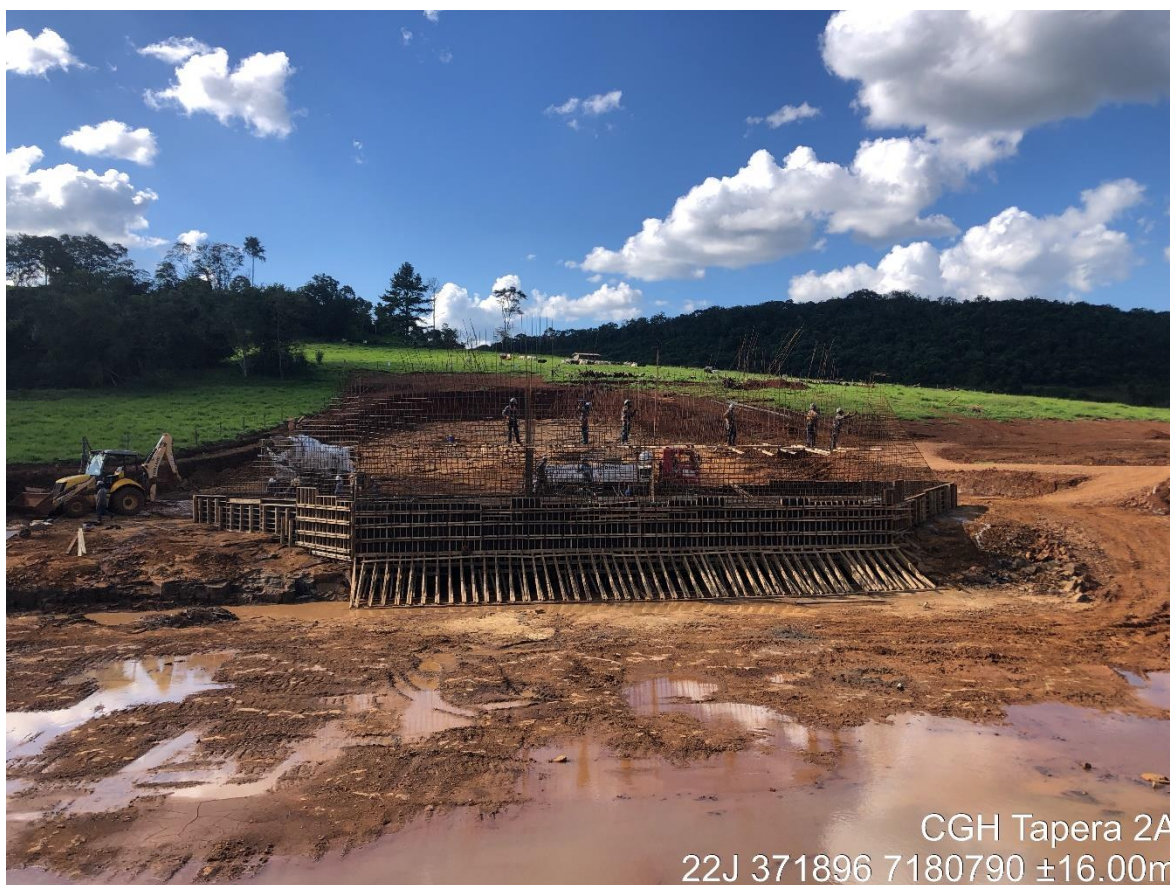
Figura 5 - Local onde está sendo construída a barragem da CGH Tapera 2A, 29/03/2022.
