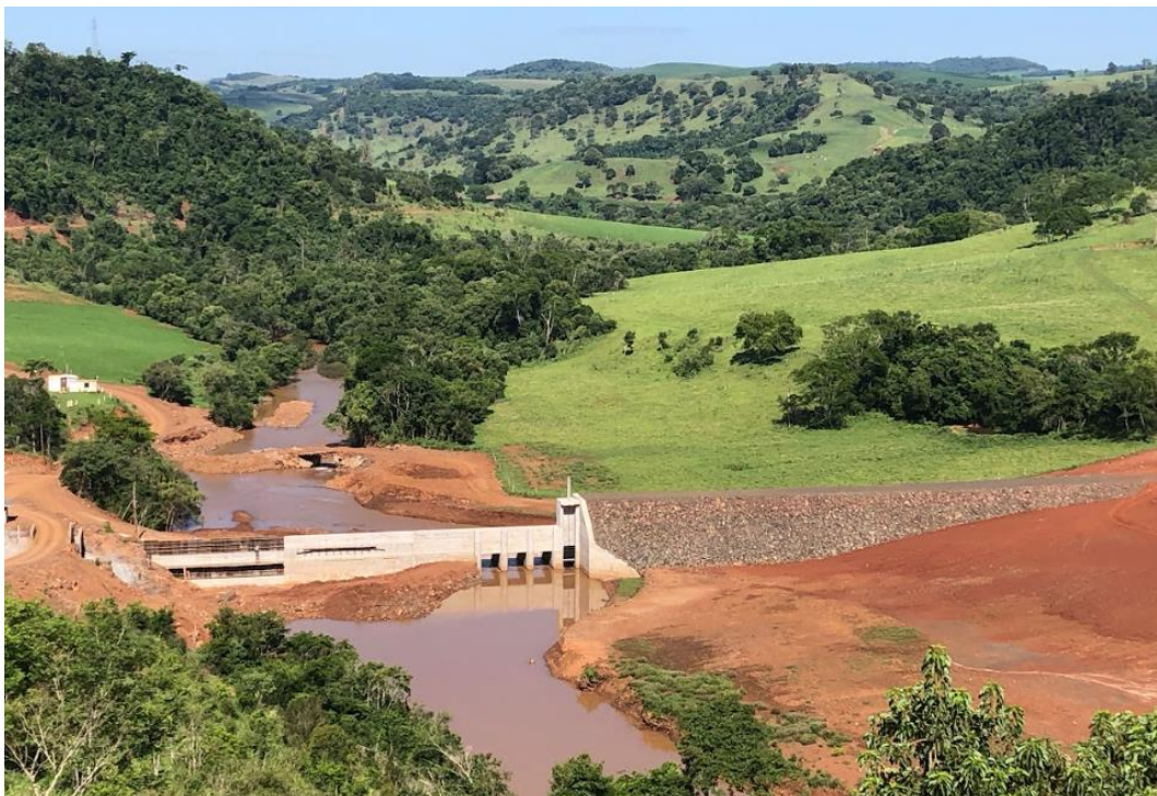
Figura 4 – Vista da barragem (obra ainda não terminada) (dezembro/2022).
