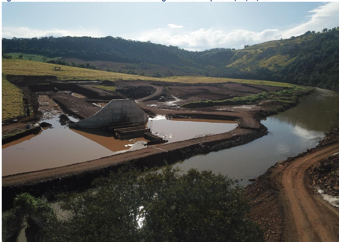
Figura 7 - Local onde está sendo construída a barragem da CGH Tapera 2A, 15/06/2022.
