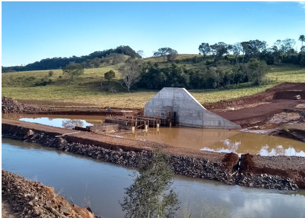
Figura 6 - Local onde está sendo construída a barragem da CGH Tapera 2A, 15/06/2022.
