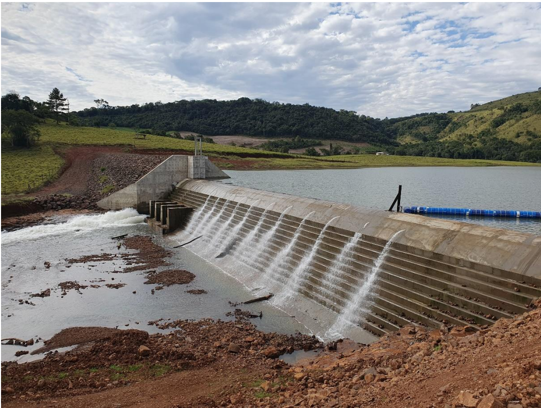
Figura 2 - Enrocamento e barragem concluídos, registro após enchimento do reservatório (junho/2023).
