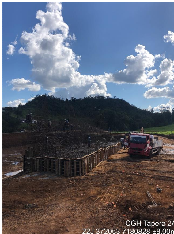
Figura 4 - Local onde está sendo construída a barragem da CGH Tapera 2A, 29/03/2022.
