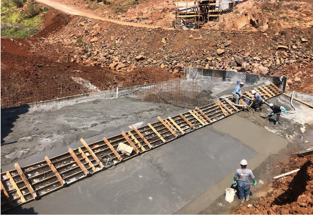
Figura 3 - Concretagem da base da barragem (margem esquerda) (setembro/2022).
