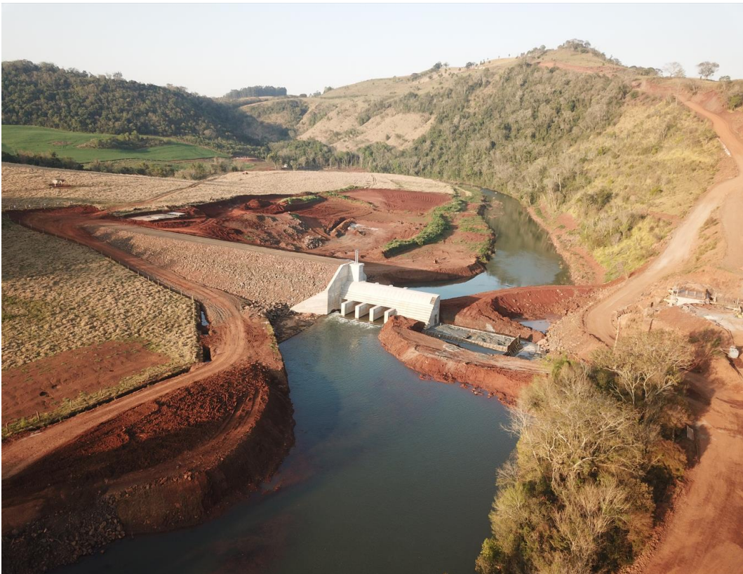
Figura 2 - Enrocamento e barragem parcialmente concluída (setembro/2022).
